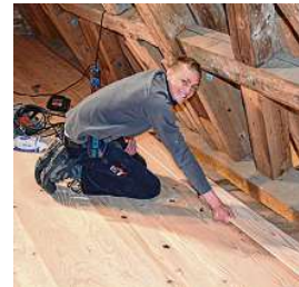
Ter Nyland von der Firma Holzbau Schmä verlegt auf dem Dachboden der Kapelle ein neues Dielenbrett aus Weißtanne.
