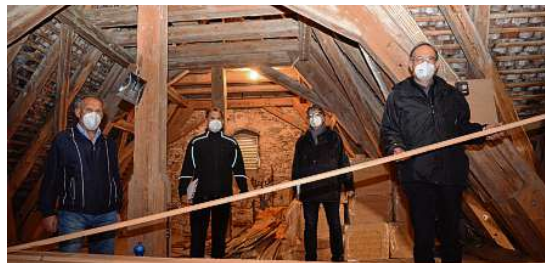
In der Baitenhausener Kapelle wird unter anderem der Dachstuhl inklusive des Bodens instand gesetzt. Pfarrer Matthias Schneider (rechts) hält eine der neuen Weißtannendielen. Von links: Mesner Karl Wengle, Zimmermeister Thomas Herrmann und Architekt Michael C. W. Günther.
