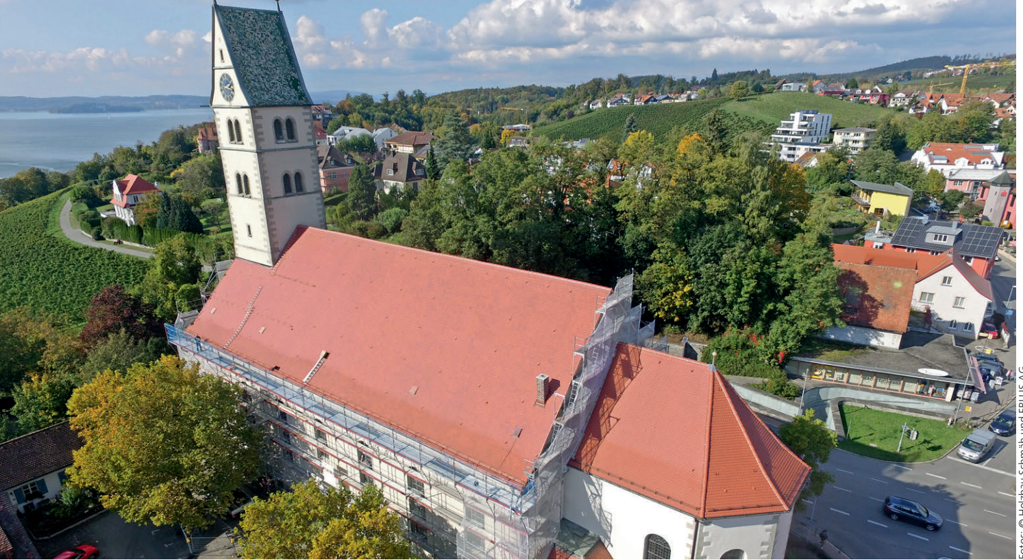
Kirchenschiff mit historischem Turm – fertige Eindeckung.
