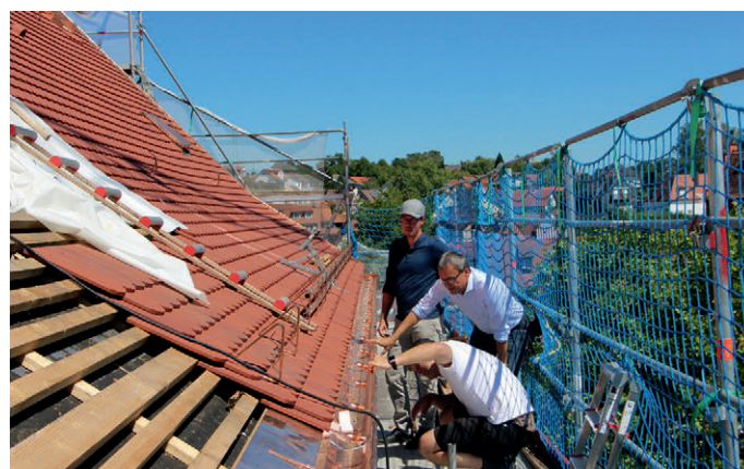
Traufaufschiebling mit Doppelrohrschneefang und Schalung und Vordeckung
